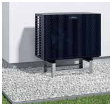
Außeneinheit der Vitocal 200-S Serie mit Bodenkonsole
